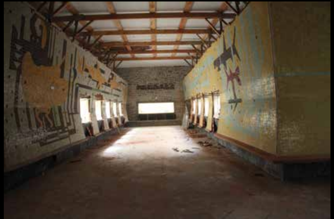
La dégradation du bâtiment, 2015
