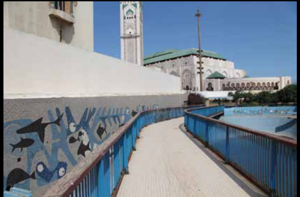
Aquarium de Casablanca, vue de l'extérieur
